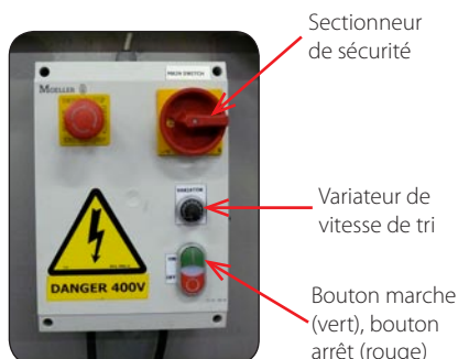
Boîtier de commande IP 65 avec variateur de vitesse de tri.
